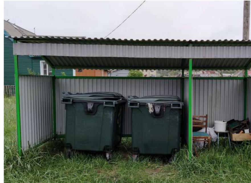
Плохо. Глухая конструкция из профнастила и яркая окраска каркаса
