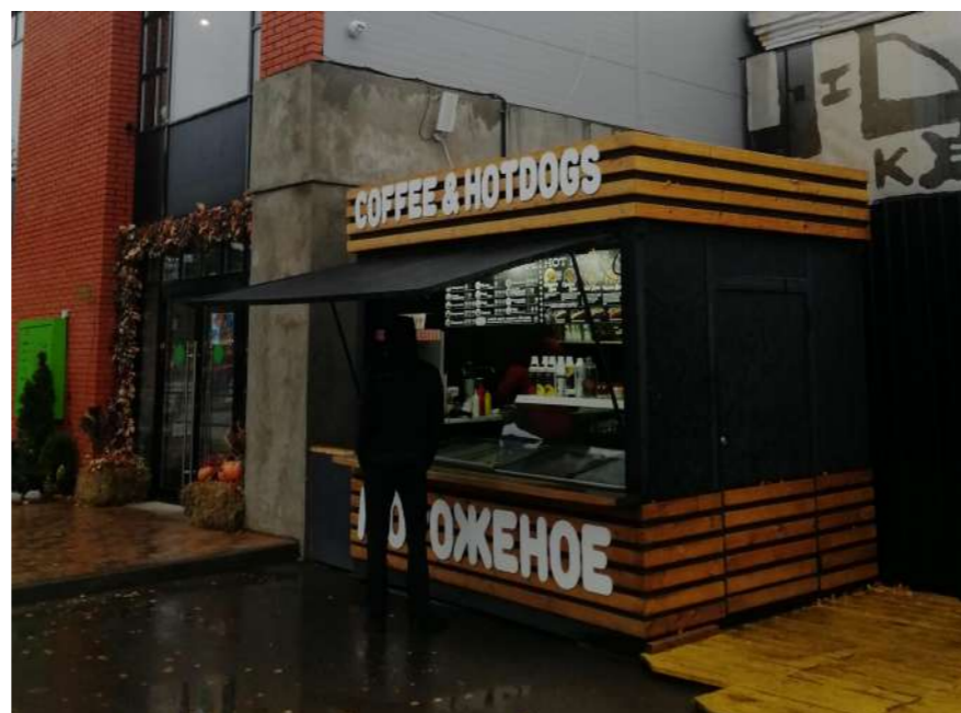
Плохо. Киоск расположен слишком близко к фасаду здания
