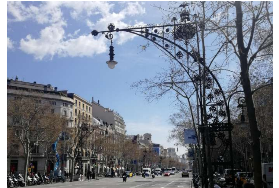
Плохо. Опоры с излишним декором
