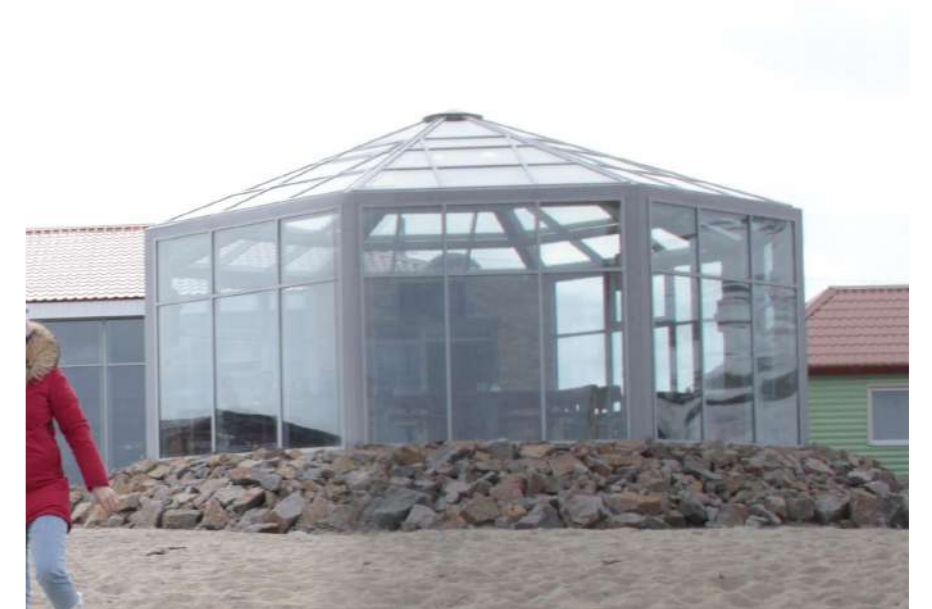
Плохо. Многоскатная шатровая кровля и шестиугольная форма блока, соединенная с простым блоком с двускатной кровлей
