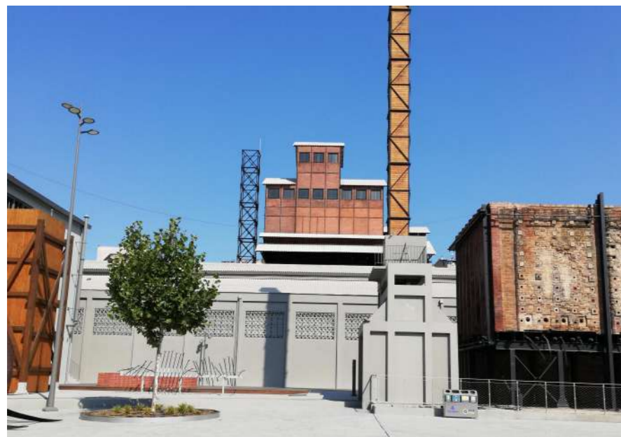
Хорошо. Проведена реконструкция исторических зданий без использования навесных фасадов
