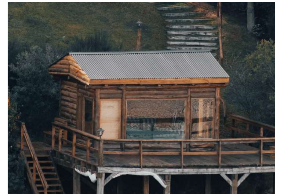
Хорошо. Подготовлено место для установки объекта
