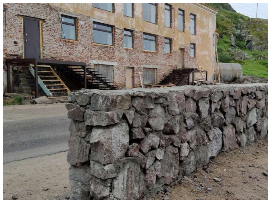
Хорошо. Ограждение из натурального камня, выполняющее роль отбойника
