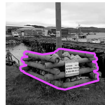
Опалубка из бревен
