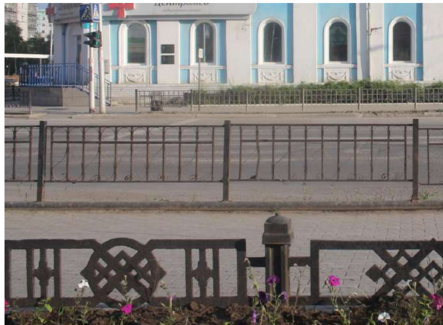
Плохо. Большое количество ограждений, часть из которых нефункциональны
