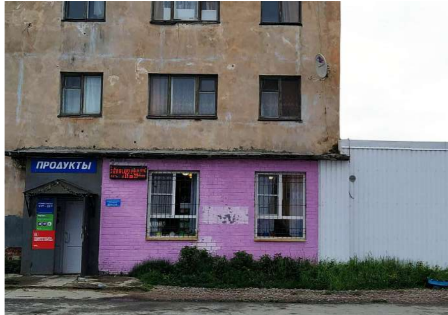
Плохо. Используются несочетающиеся цвета и фрагментарный ремонт
